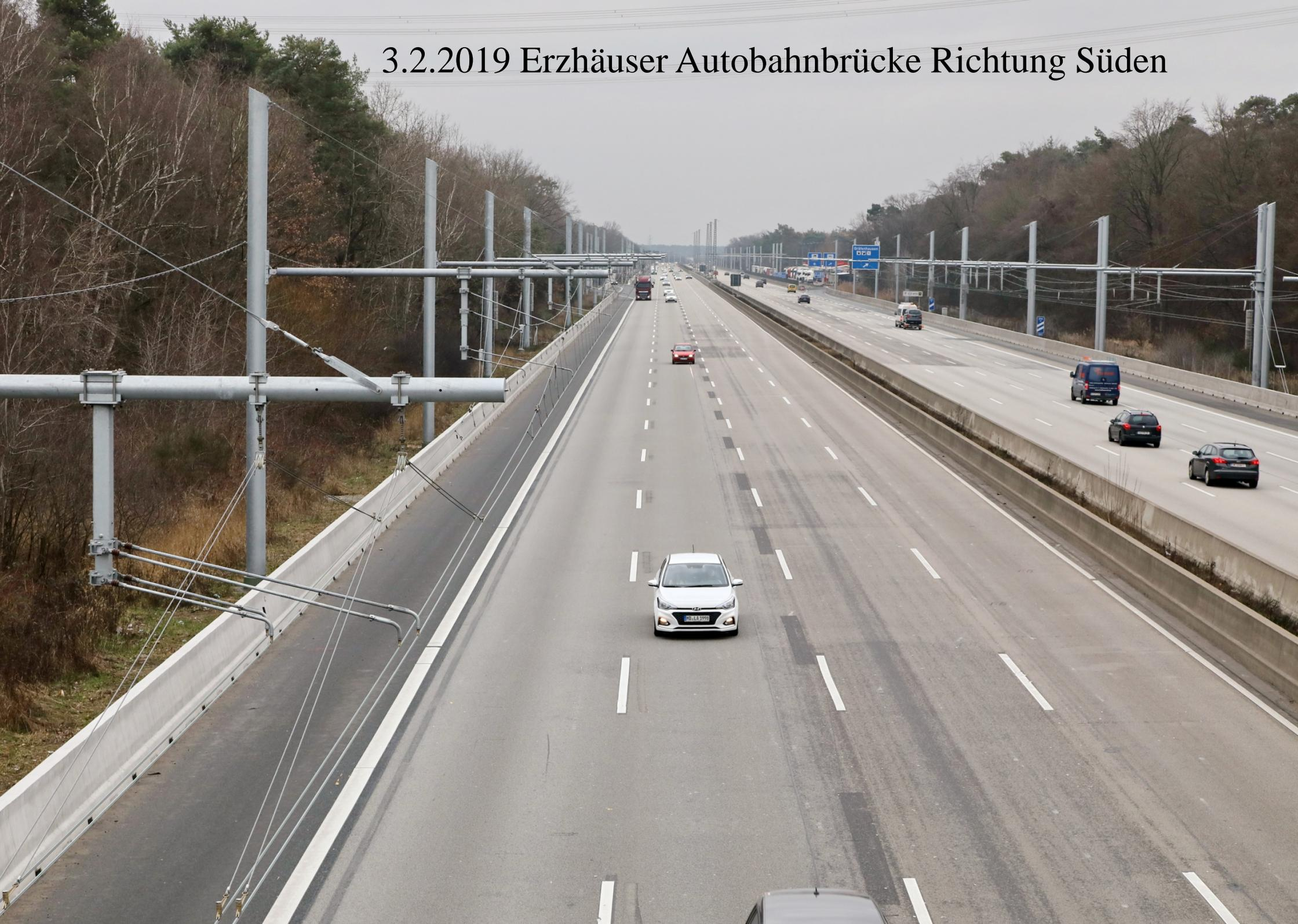
Die Oberleitungsmasten sind jeweils 13 Meter hoch, 1,5 Meter davon sind in einer Hülse im Boden verankert. Der Durchmesser der Masten beträgt etwa einen halben Meter.
